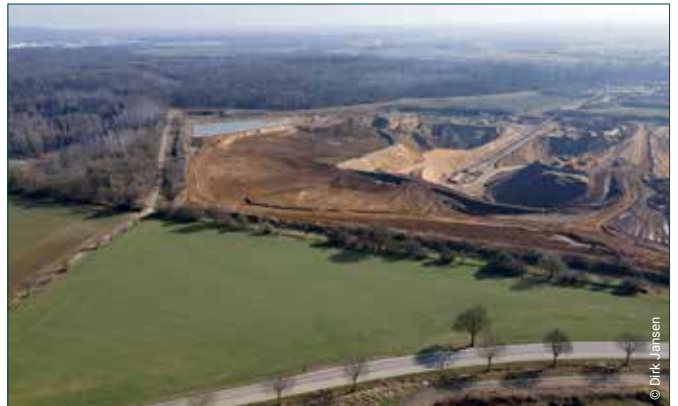
Abb. 13/14: Die Erweiterung der Kiesabgrabungen Buir (oben) und Forster Feld (unten) wurden unlängst genehmigt.
