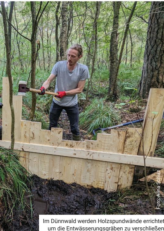
Im Dünnwald werden Holzspundwände errichtet, um die Entwässerungsgräben zu verschließen.
