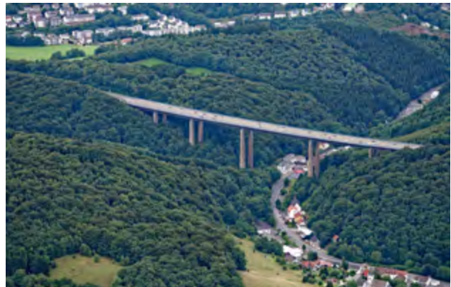
Die marode Rahmedetalbrücke der A45 musste 2021 wegen irreparabler Schäden aufgrund unterlassener Investitionen gesperrt werden
