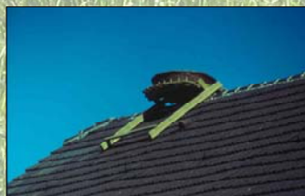
Nisthilfe auf dem Dach einer Scheune am Rande der Rheinaue
